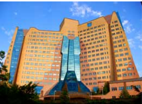
Het Gasuniegebouw, in de volksmond 'de Apenrots'
